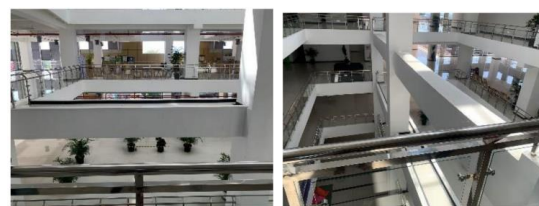
Gambar 9. Ekspos pembalokan dalam bangunan
