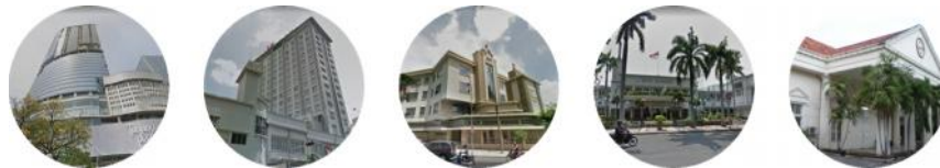
Gambar 9. Kondisi visual arsitektur yang mendominasi Tunjungan (Sumber: Foto Jalan Google, 2017)
