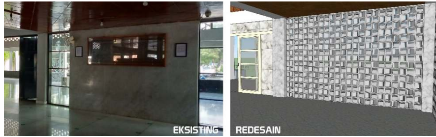
Gambar 8. Material roster diaplikasikan ke dinding ruang sholat (Sumber: Hasil analisa, 2021)
