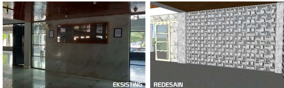
Gambar 4. Material roster menggantikan material dinding batu bata (Sumber: Hasil analisa, 2021)
