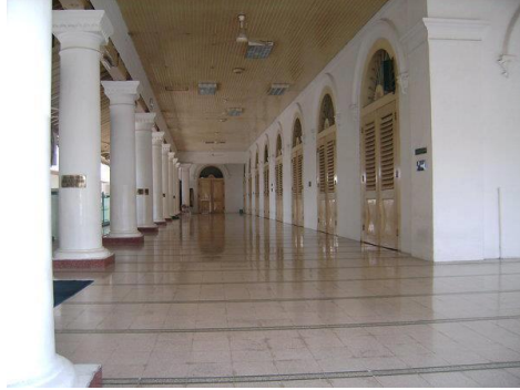
Gambar 7. teras sebagai ruang peralih yang mengurangi panas
